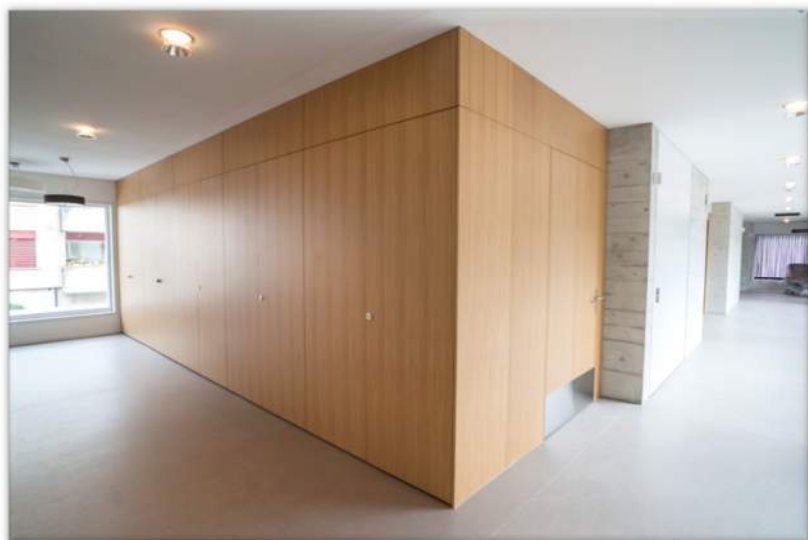
Brandschutzabschlussfront in horizontalem Fluchtweg
